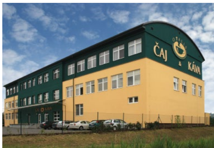
Přístavba dalšího patra - rok 2007
