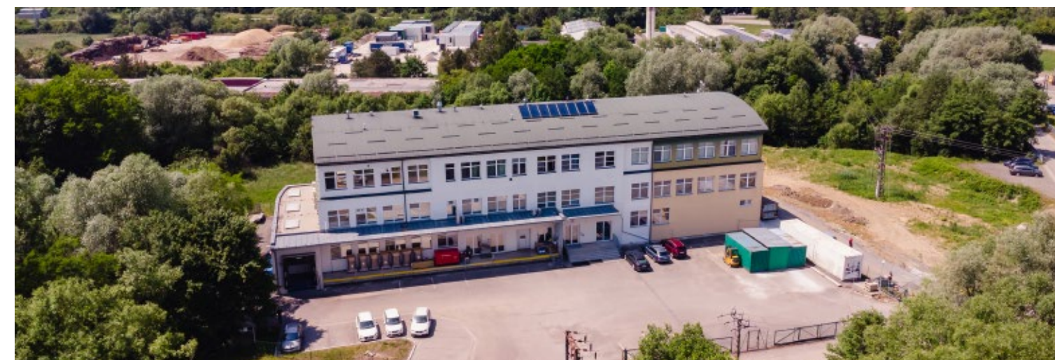
Sídlo společnosti ve Slušovicích – červen 2023
