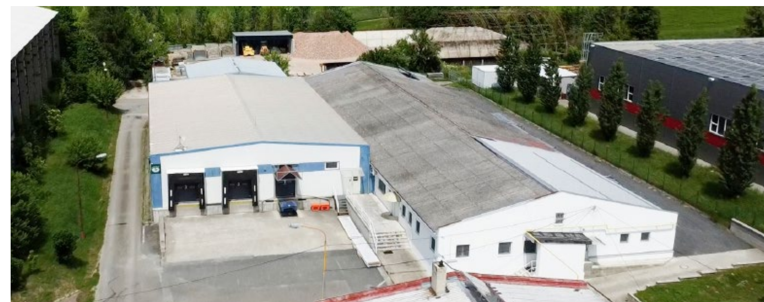
V roce 2015 proběhlo zakoupení a rekonstrukce budov expedičního skladu v Tečovicích
